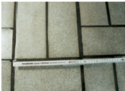
Vorteilhafte Fliesen- größe und -farbe auf freibewittertem Gussasphaltestrich.
