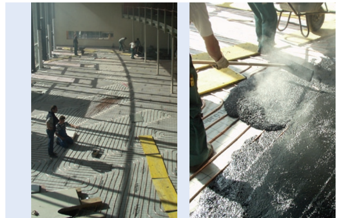
Zwei Baustoffe, ein System: geschliffener Gussasphalt-Heizestrich mit hartgelöteten Kupferrohrleitungen in der Aula einer Fachhochschule
