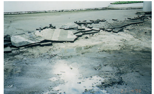
Abriss schadhafter Deckschicht auf Parkdeck
