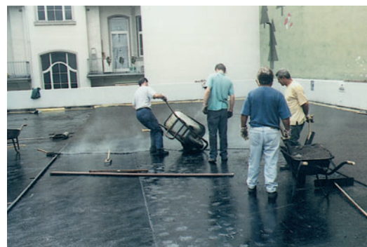
Einbau der Gussasphaltschutzschicht
