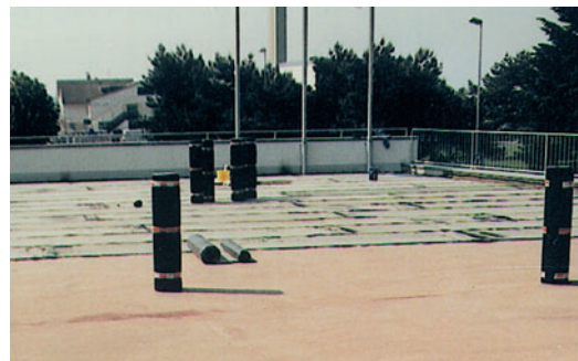
Einbau der Bitumen-Schweißbahnen auf der versiegelten Betonfläche
