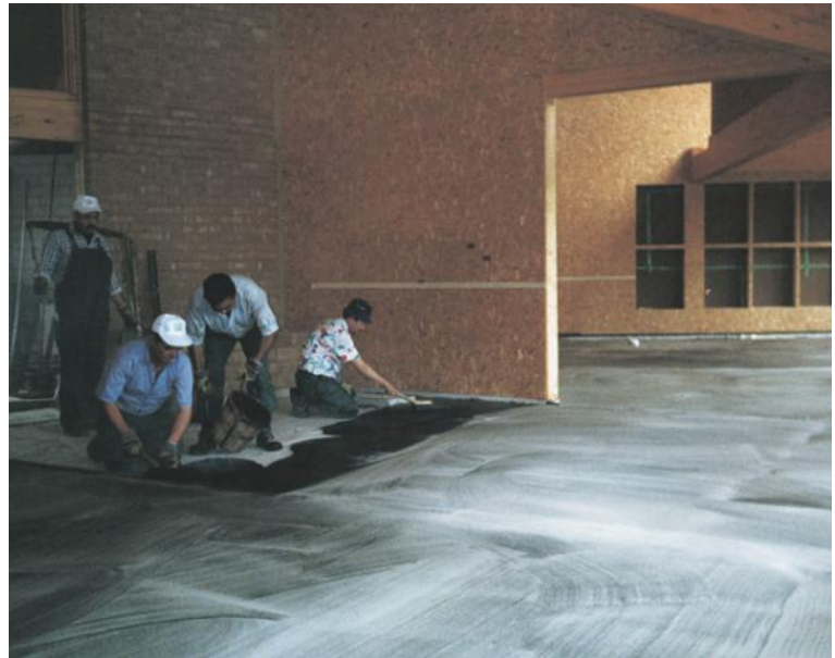
Einbau und fertige Fläche
