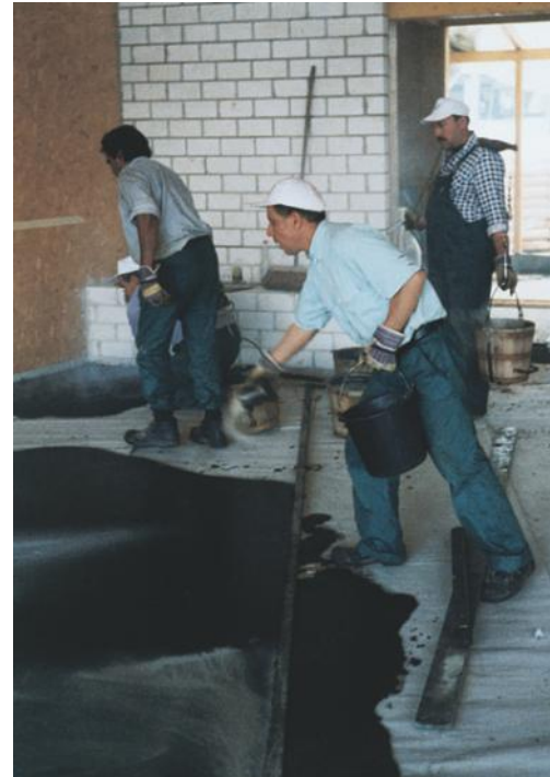
Einbau und fertige Fläche
