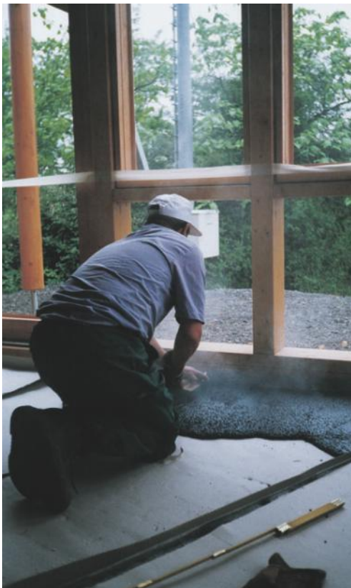
Einbau von Gussasphaltestrich auf Dämmschicht
